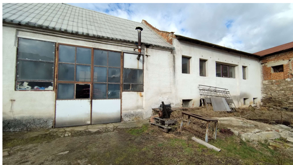
Foto – Pohled ze dvora. Prosklená vrata do budovy na p.č. 366 bez čísla popisného, vpravo těsně přiléhající objekt v soukromém vlastnictví na pozemku p.č. 368.
