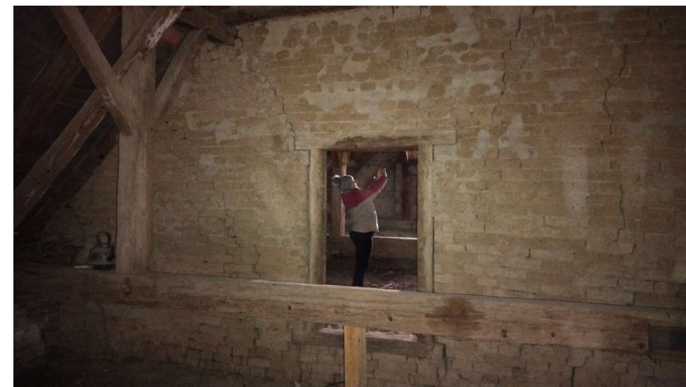
Foto - Půdní prostor nad hlavní obytnou částí.
