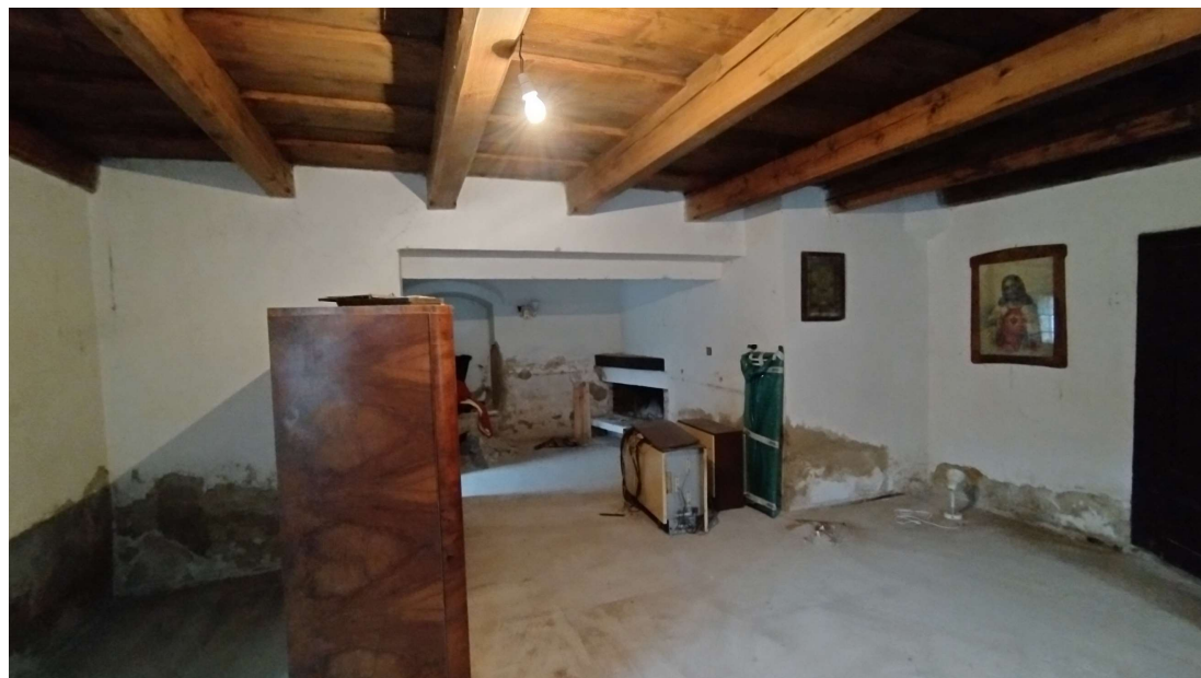
Foto – Interiér obytné části, hlavní obytná místnost, vzadu krbová kamna
