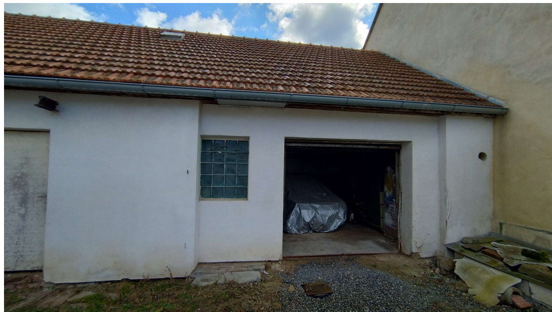
Foto – Pohled ze dvora, č.p. 1 dílna v místě bývalých hospodářských budov.
