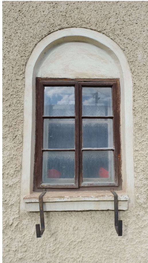
Foto – Detail historického původního okna, detail zdi ze smíšeného zdiva s původními otvory.
