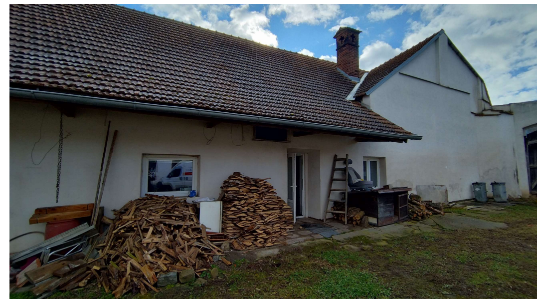
Foto – Pohled na obytnou část budovy č.p. 1 ze dvora, viditelná opravená fasáda a vyměněná plastová okna. V levé části okno do kanceláře autodílny, uprostřed dveře do středové chodby, vpravo okno do kuchyně.
