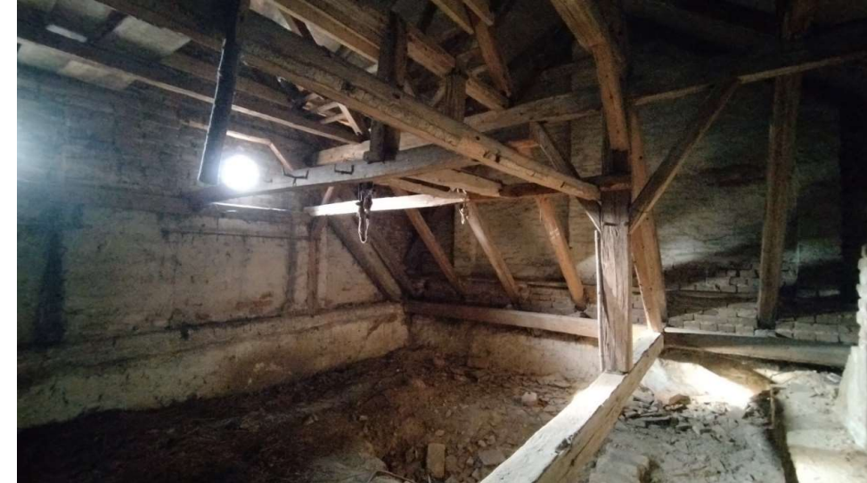
Foto – Půdní prostor nad hlavní obytnou částí.
