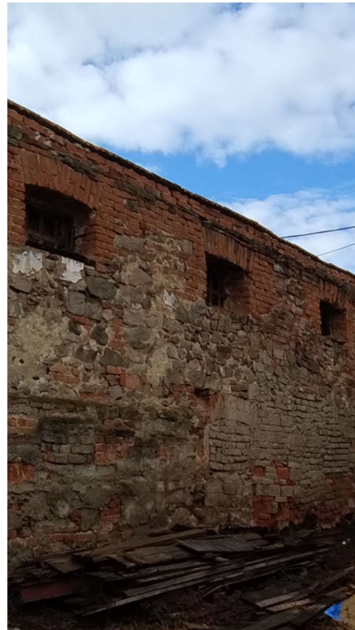
Foto – Detail historického původního okna, detail zdi ze smíšeného zdiva s původními otvory.
